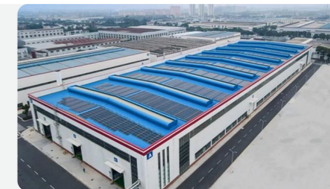
厂房屋顶光伏电站
