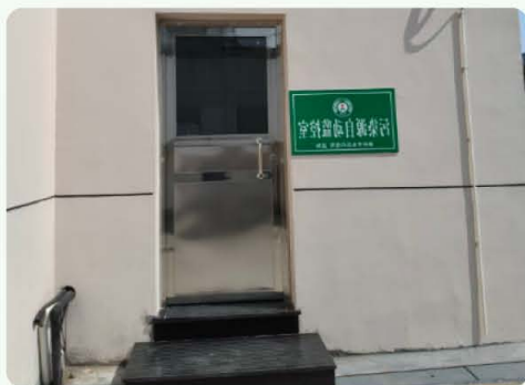
海阳锦纶新建污水处理在线监控站房
