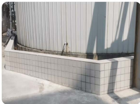
海阳锦纶罐区增设围堰，降低原料泄漏污染风险。
