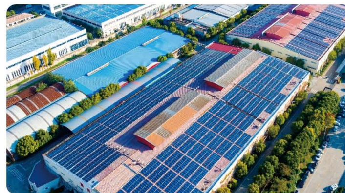
屋顶分布式光伏电站
