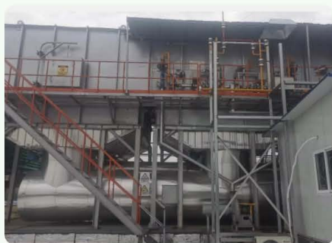
海阳锦纶浸胶车间新建一套RTO废气处理装置
