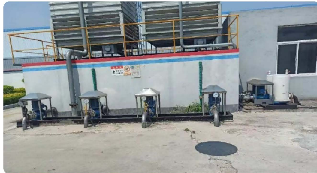
华恒厂区利用循环水代替冷却水，降低水浪费90%
