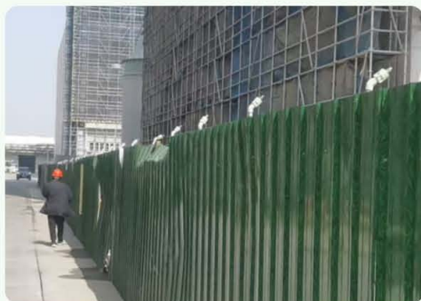
海阳锦纶施工现场增设喷淋除尘，裸土防尘网覆盖
