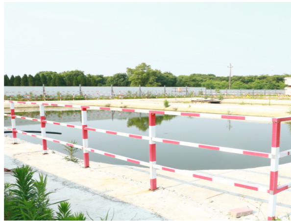
交工宏途建设雨污分离循环池
