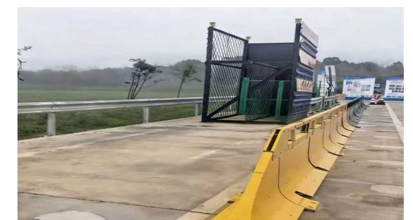
闲置铁马升级改造的公路防撞缓冲装置
