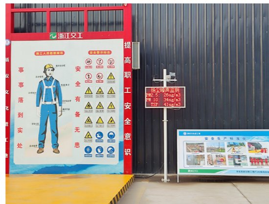
施工现场扬尘噪声在线检测设备
