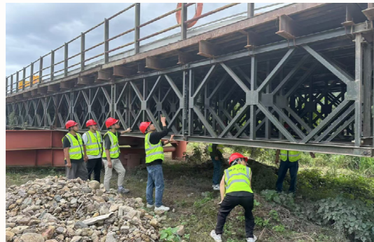
港航工程项目部联合监理等单位开展联合检查
