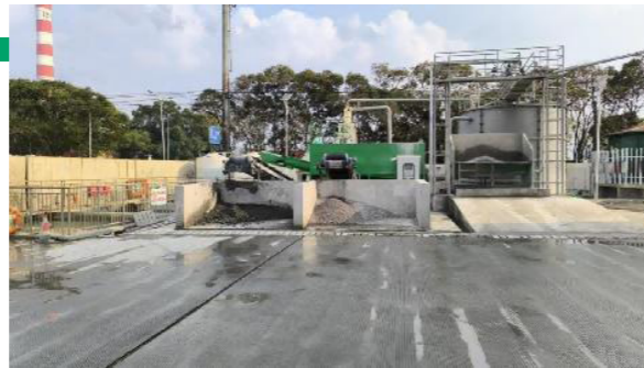
浆液残余回收处置工艺实现砂石分离
