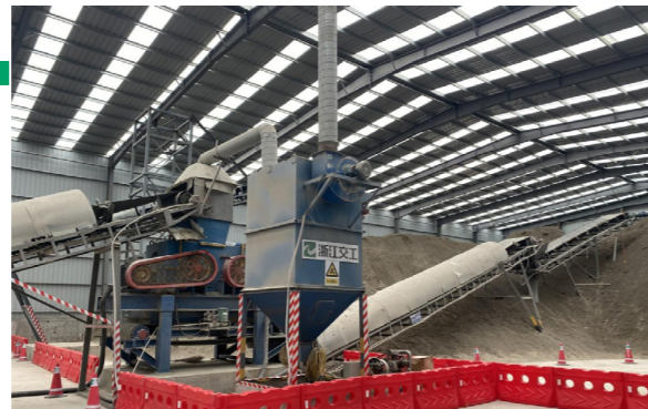
改良粉质钻渣工艺破碎生产线作业现场
