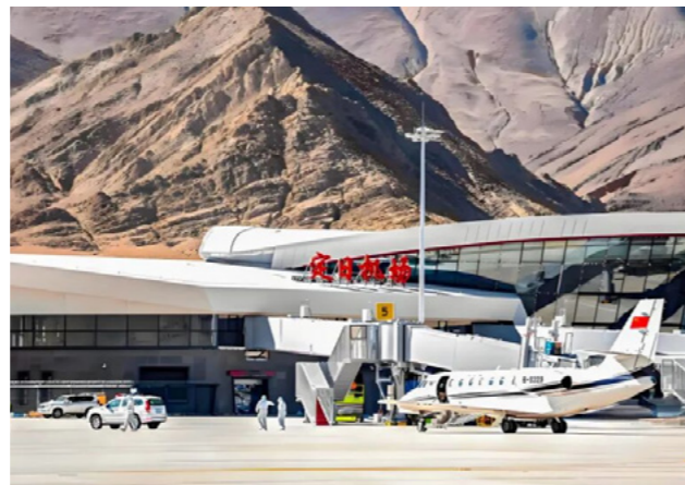
日喀则定日机场配电监控系统和能源管理系统建设
