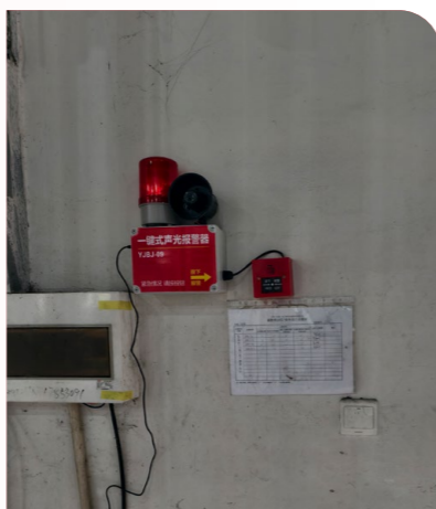
员工宿舍、车间加装一键消防报警装置
