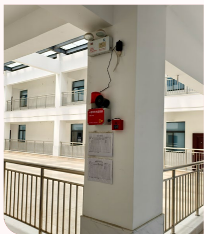
员工宿舍、车间加装一键消防报警装置
