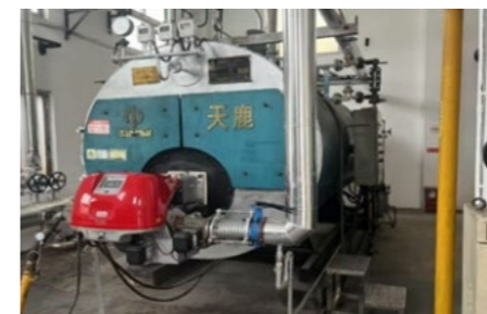
改造后的承压蒸汽锅炉
