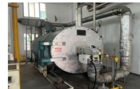
改造后的有机热载体气相炉
