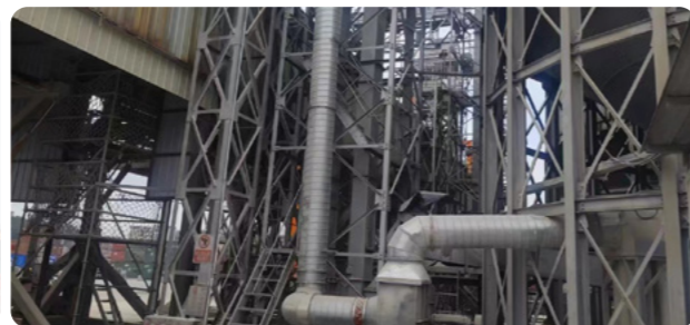
粮食筒仓作业区装车道除尘系统升级改造
