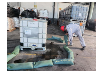
搭建围堰，收集废液
