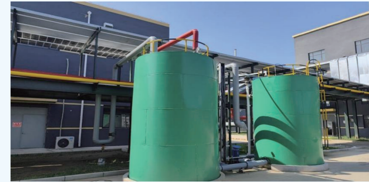
● 蒸汽冷凝水回收利用 (辽宁基地)
