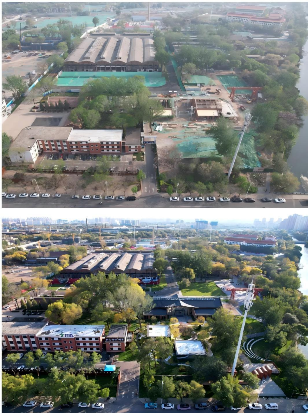
▲津一·PARK：天津市第一机床总厂改造更新前后
