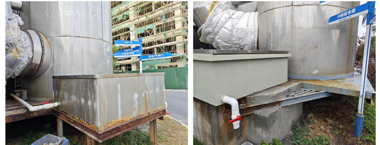
整改前后废气喷淋塔水槽及平台
