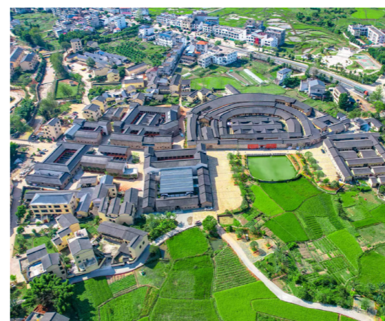
▲ 江西“世界客家第一村”顺利通过竣工验收
