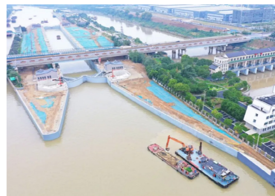
▲ 谏壁一线船闸扩容改造工程通过验收，打造世界级内河枢纽
