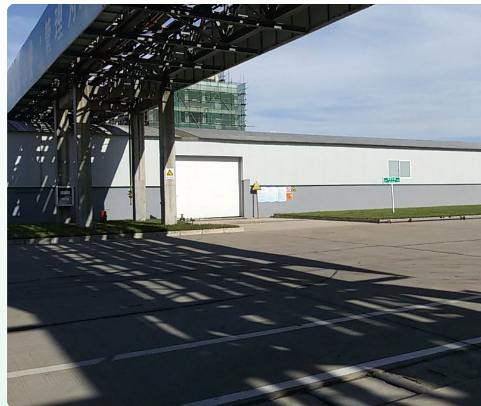
南通基地危废仓库
