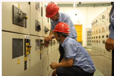
实施电力设备预防式巡修
