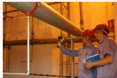
开展 110kV 变电站电力 变压器红外监测
