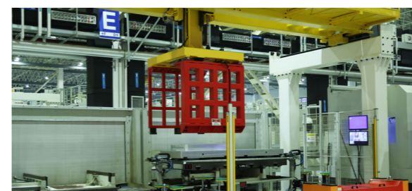
“黑灯工厂”生产现场
