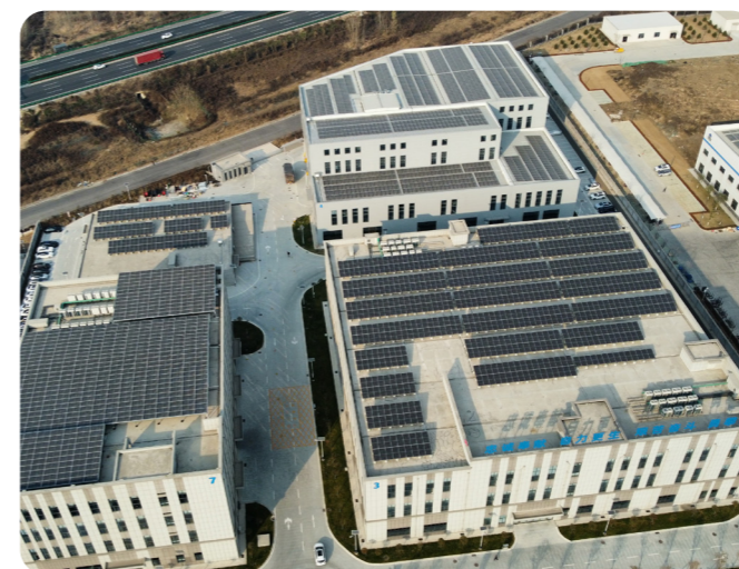
电测光伏发电项目
