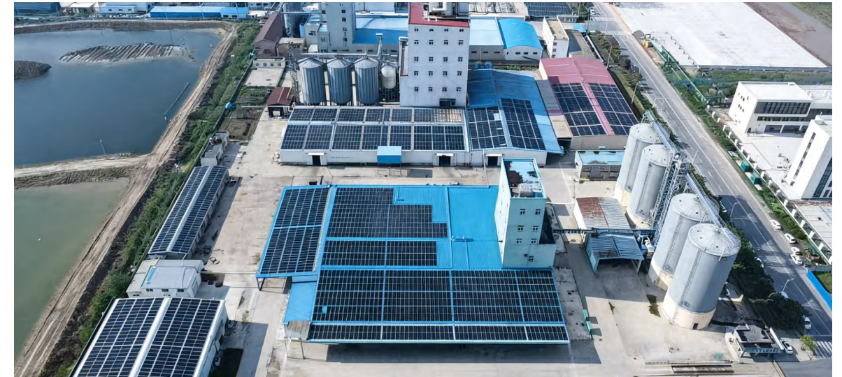
射阳六和饲料公司厂区光伏项目于 2025 年 6 月 15 日并网发电。
