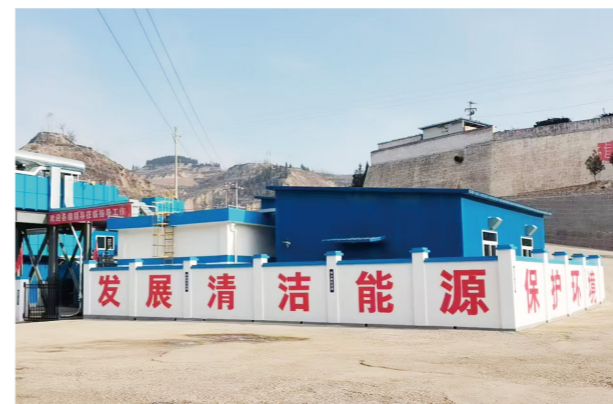
山西兴无煤矿瓦斯综合利用项目
