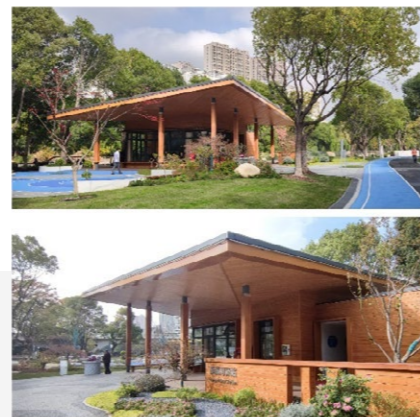
梁溪河驿站 (钢木结构)
