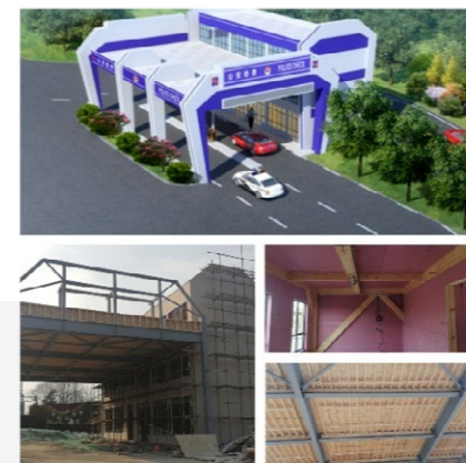
沪宁高速公路无锡东收费站公安检查站 (胶合木结构)
