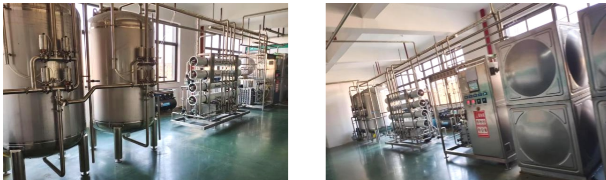
循环水系统建设
