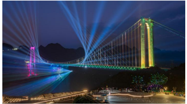
花江峡谷大桥主桥项目
