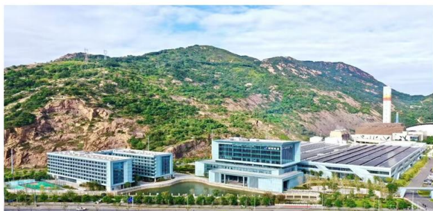
伟明装备集团装备制造产业基地
