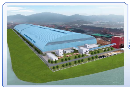
图示：福建储运煤炭储备项目
