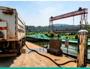
雨水过滤系统升级改造现场
