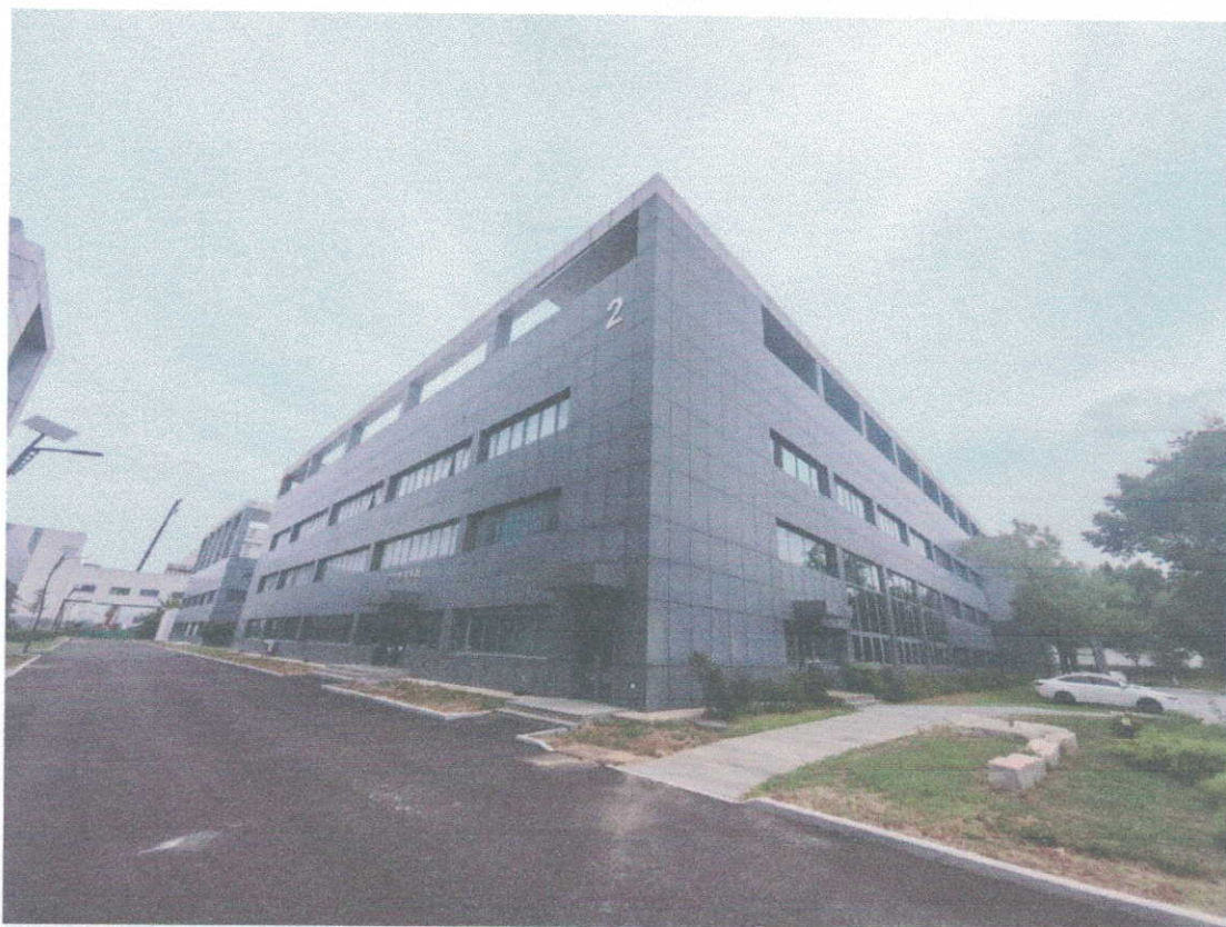
惠河路-90-2 号固体制剂车间
