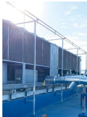
制冷机组 (带 Freecooling 功能)
