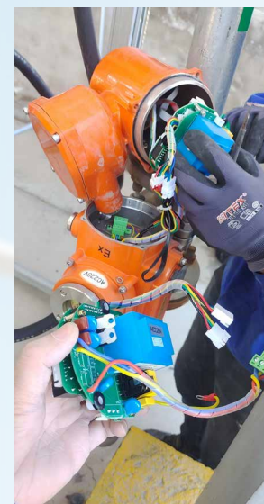
防爆电动调节 执行机构修复
